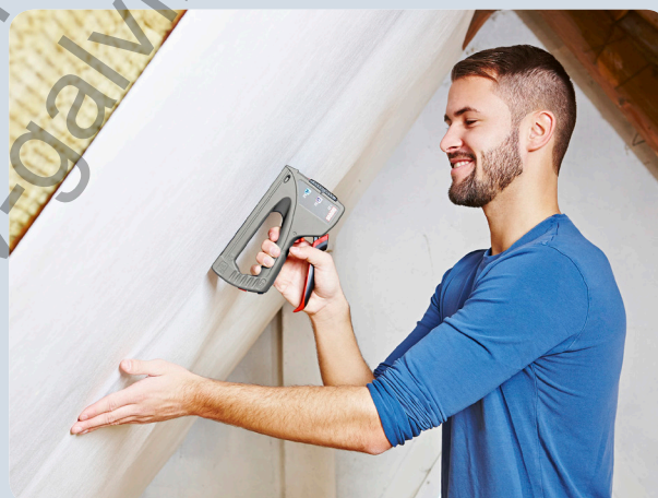
Folie beim Dachbodenausbau einfach befestigen.
